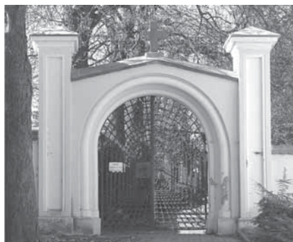
Tak vypadala před rekonstrukcí.
