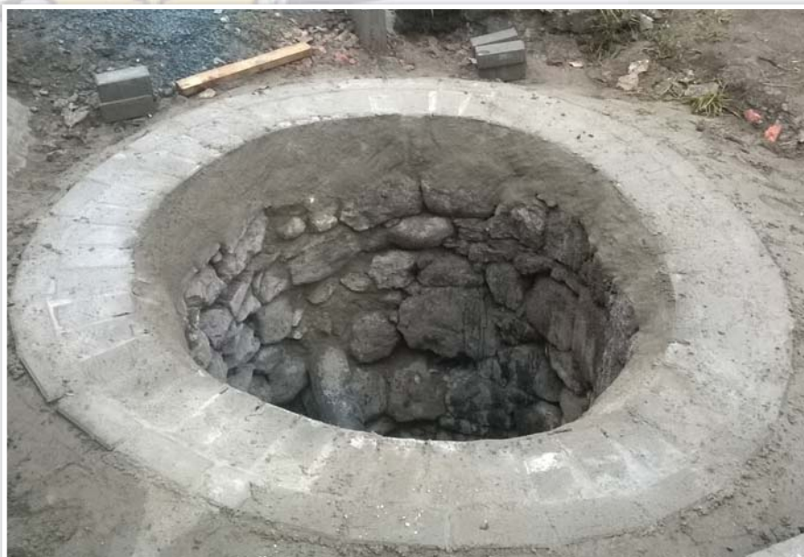
Rekonstrukce studny na ulici Zborovská
